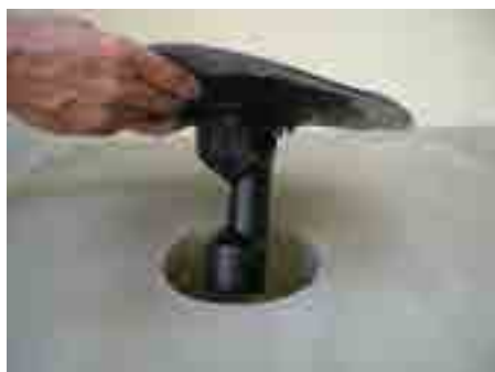
1. Поставете сифонното тяло с предпазен капак в отвора на покривната конструкция
