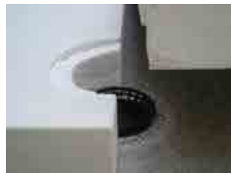
3. Положете разделящ слой, дренажен пръстен (HL180) върху сифонното тяло, положете и топлоизолацията
