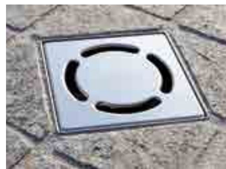
6. Дренажния пръстен и наставката се опаковат с геотекстил, полага се филцова настилка и бетонни плочи върху нея, поставя се решетката
