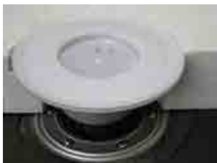
4. Удължителен елемент с фланец за хидроизолацията (HL85N) се срязва и се регулира на височината на топлоизолацията, поставя се върху дренажния пръстен (HL180), монтира се предпазния капак
